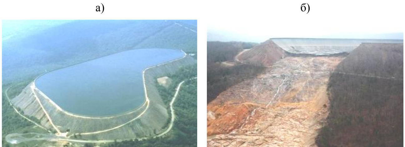
Рис. 3.6. Верховий басейн ГАЕС Таум Саук (США) до (а) та після аварії (б) 2005 р.
