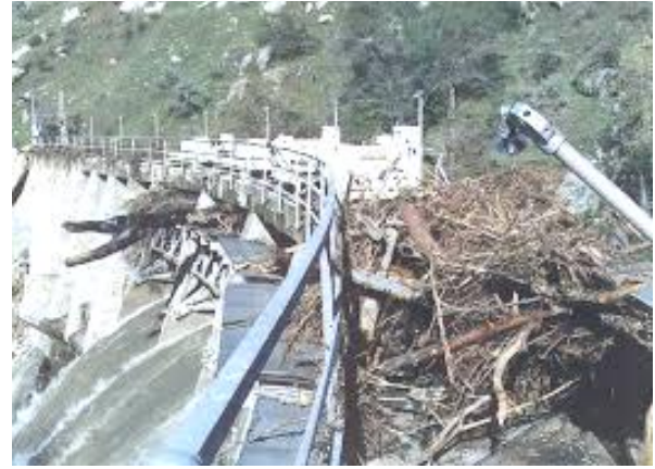
Блокування водоскиду греблі Керкхоф в 1997 р. (р. Сан Хоакін, Каліфорнія, США)
