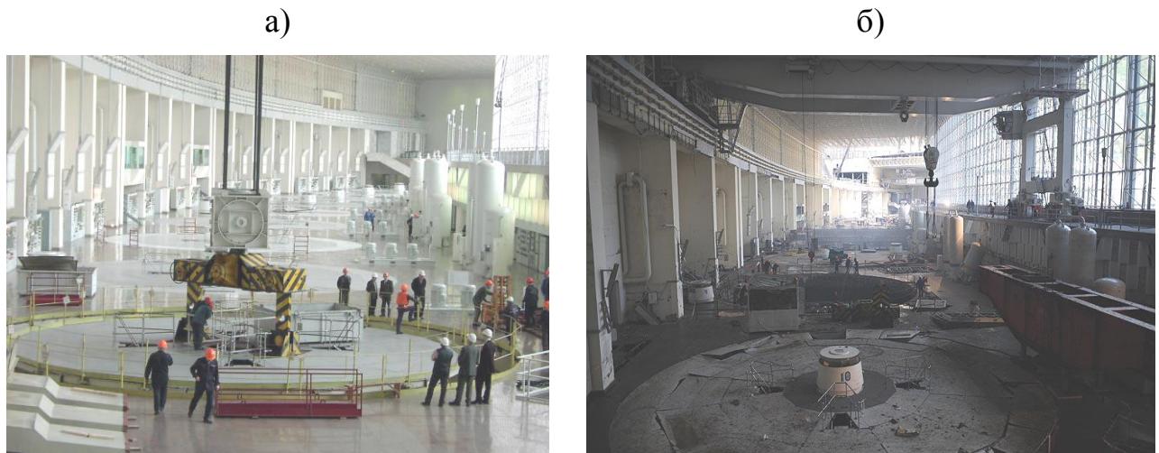
Рис. 3.2. Машинний зал Саяно-Шушенської ГЕС до (а) та після аварії (б) 2009 р.
