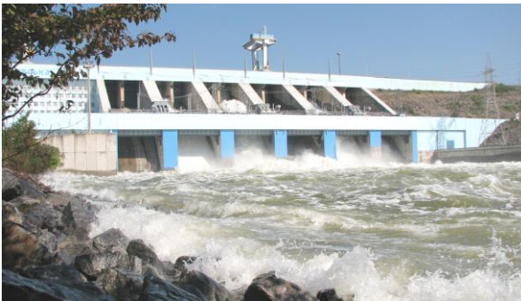
Пропуск паводку через поверхневий водозлив на Дністровському гідровузлі (р. Дністер, Україна)
