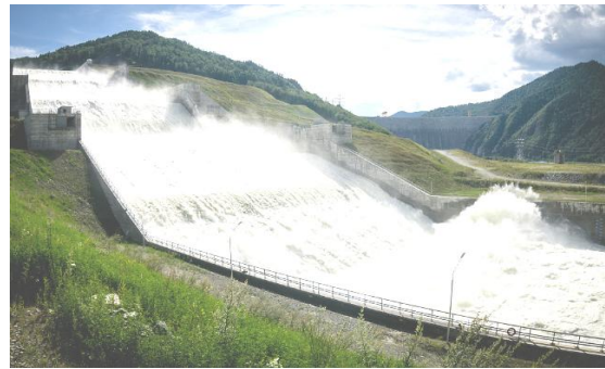
Пропуск паводку через береговий водоскид Саяно-Шушенського гідровузла (р. Єнісей, Росія)
