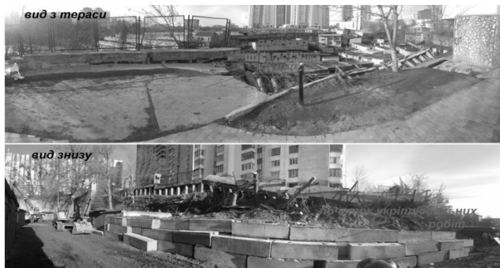
Рис. 4. Характер руйнування підпірної стінки
