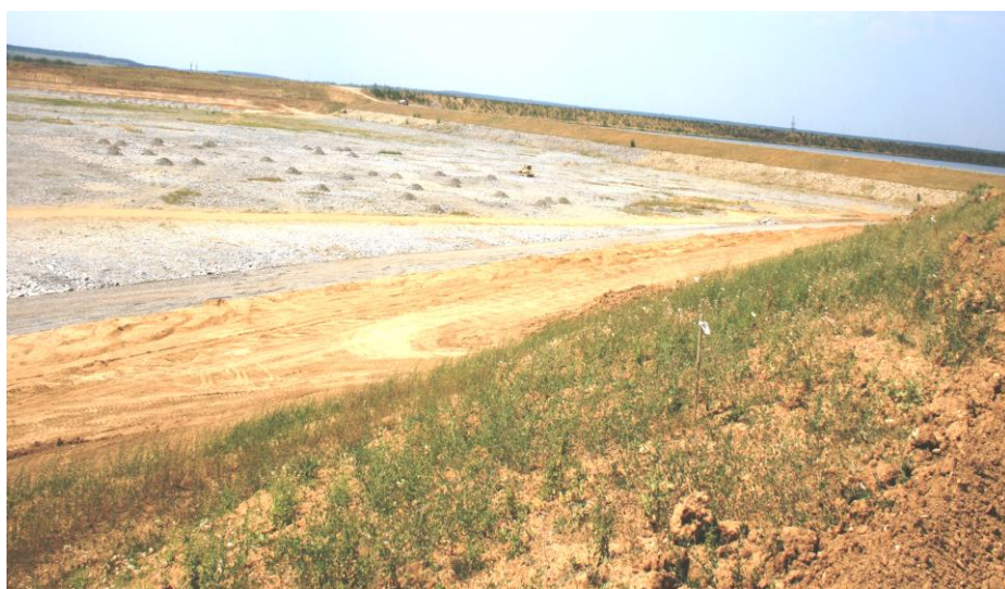
Рис. 2 - Будівництво другої черги екрану верхового басейну Дністрівської ГАЕС (укладка захисного кам'яного накиду поверх екрану)
