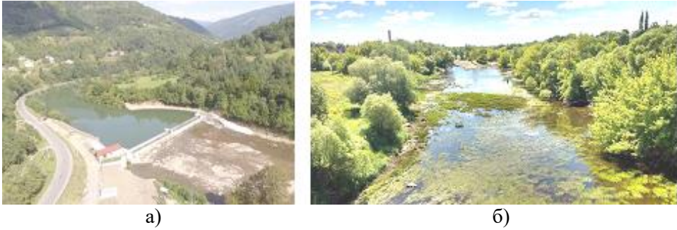
Рисунок 3 – Стан нижніх б'єфів «найсучасніших» МГЕС в Україні: а) МГЕС в с. Нижній Бистрий (фото О. Станкевич-Волосянчук); б) Чижівська МГЕС на р. Случ
