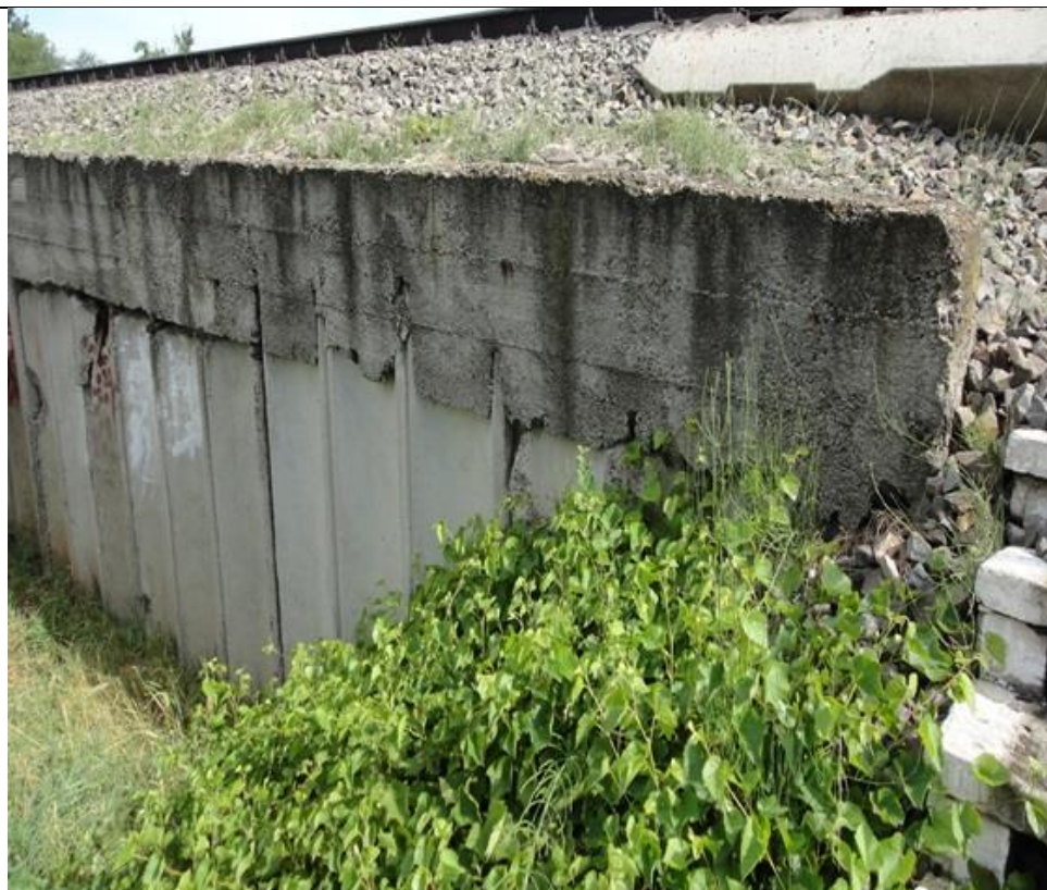
Рис. 3.8. Загальний вигляд залізничної підпірної стіни одноколіїної залізниці.
