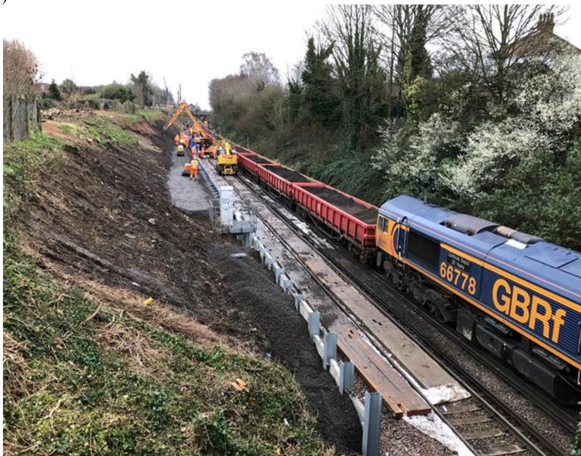
Рис. 3.5. Сучасне будівництво залізничної ПЗС (а,б).
