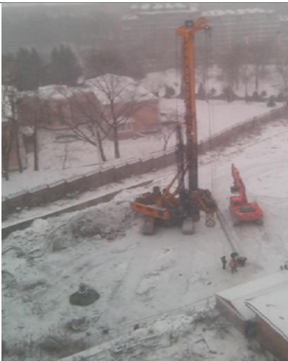
Рис. 4.9 – Розташування майданчика будівництва біля підніжжя будинку по вул. Пимоненка, 14 (фото з квартири на 9-му поверсі).
