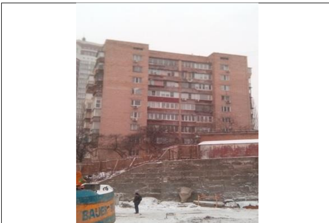
Рис. 4.2 – Вид на досліджувану будівлю включно з підпірною стіною
