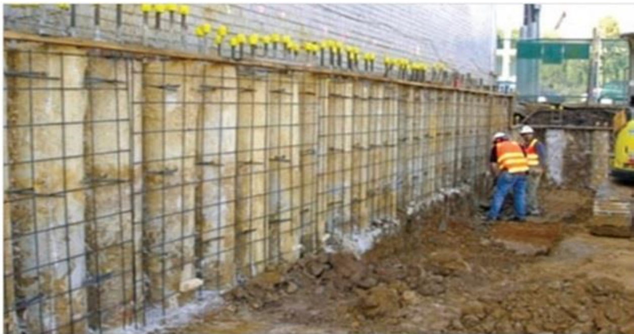
Рис. 1.14. Стіна із ЗП. Арматурна сітка розміщена фронтально перед палями та готова для наплення торкрету. Місцерозташування – Brighton, Мельбурн, Австралія. (Фото надано Basement Construction Services, штат Вікторія, Австралія).[170]
