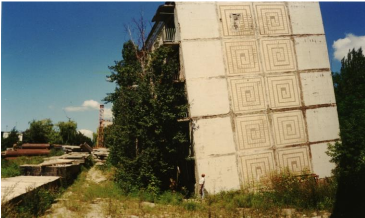
Рис. 1. Крен п'ятиповерхового будинку в м. Кам'янське внаслідок прориву водогінних комунікацій.
