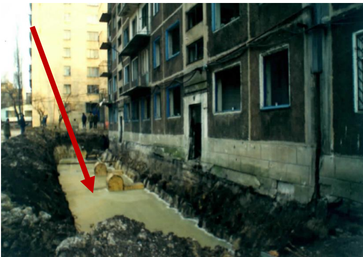
Рис. 3. Затоплення котловану з буровим обладнанням при виконанні робіт з усунення крену п'ятиповерхового великопанельного будинку внаслідок аварійного прориву водопроводу (м. Селідово).
