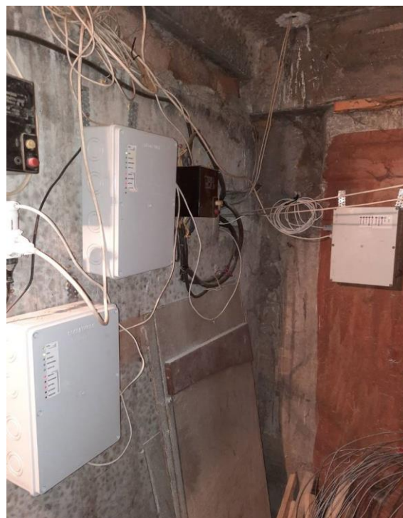
Рис. 4.2. Зовнішній вигляд блоку збору та передачі інформації.
