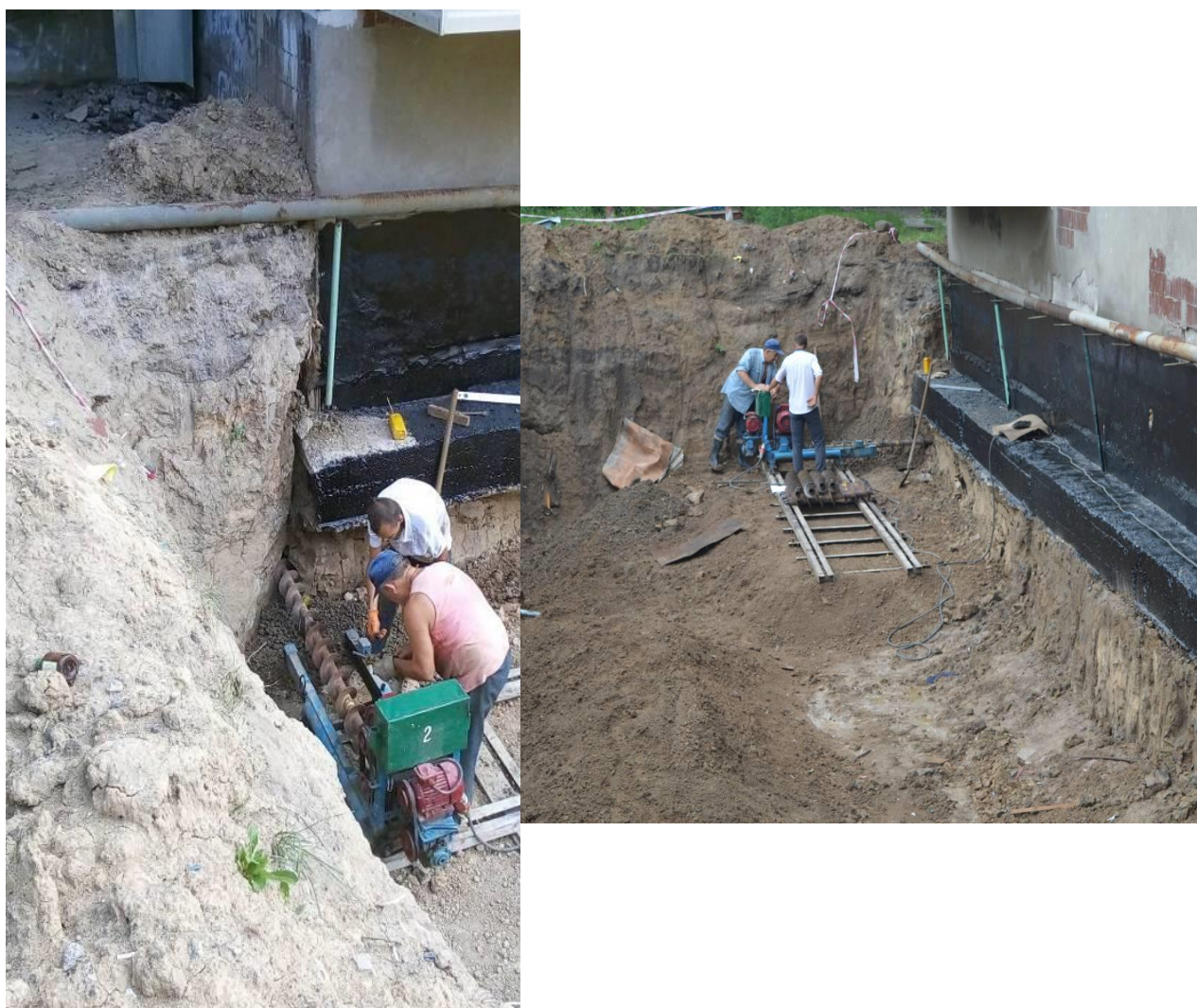
Рис. 4.5. Процес виконання бурових робіт верхнього ряду.
