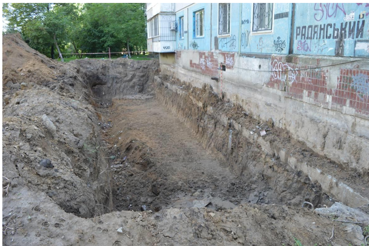
Рис. Г7.2 – Зовнішній вигляд відкопаного котловану.
