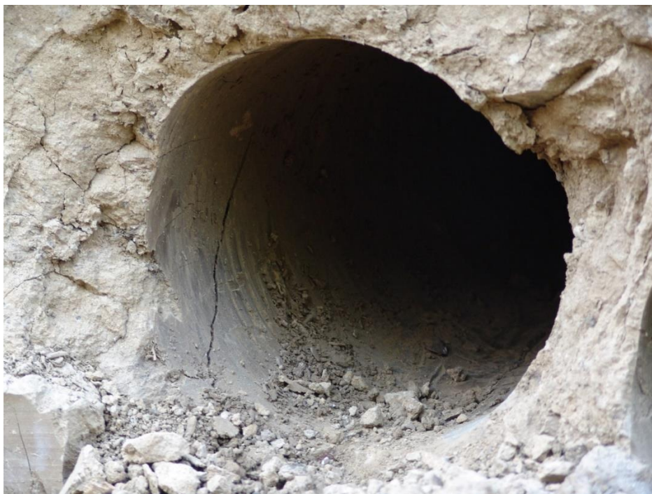
Рис. 2.29. Характерний контур свердловини з боку котловану після буріння.
