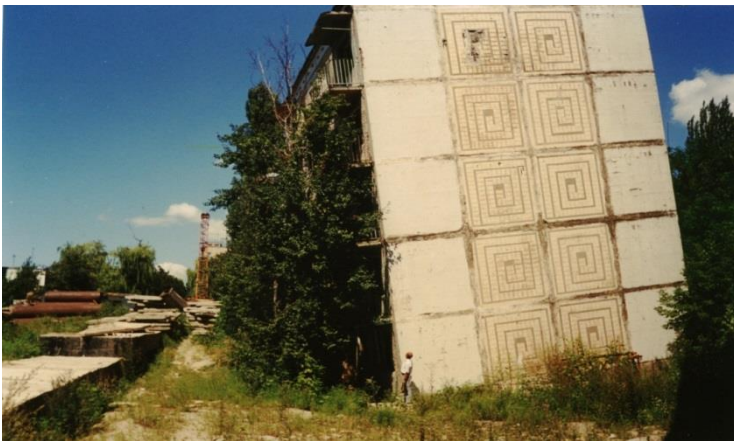
Рис. 0.1. Крен п'ятиповерхового будинку в м. Кам'янське внаслідок прориву водогінних комунікацій.
