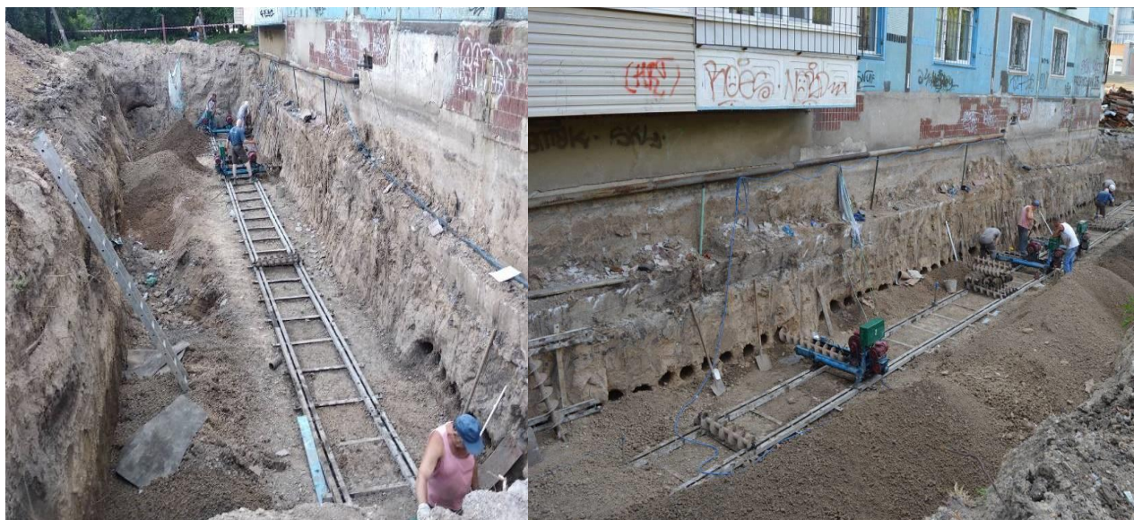
Рис. 4.4. Процес виконання бурових робіт нижнього ряду.
