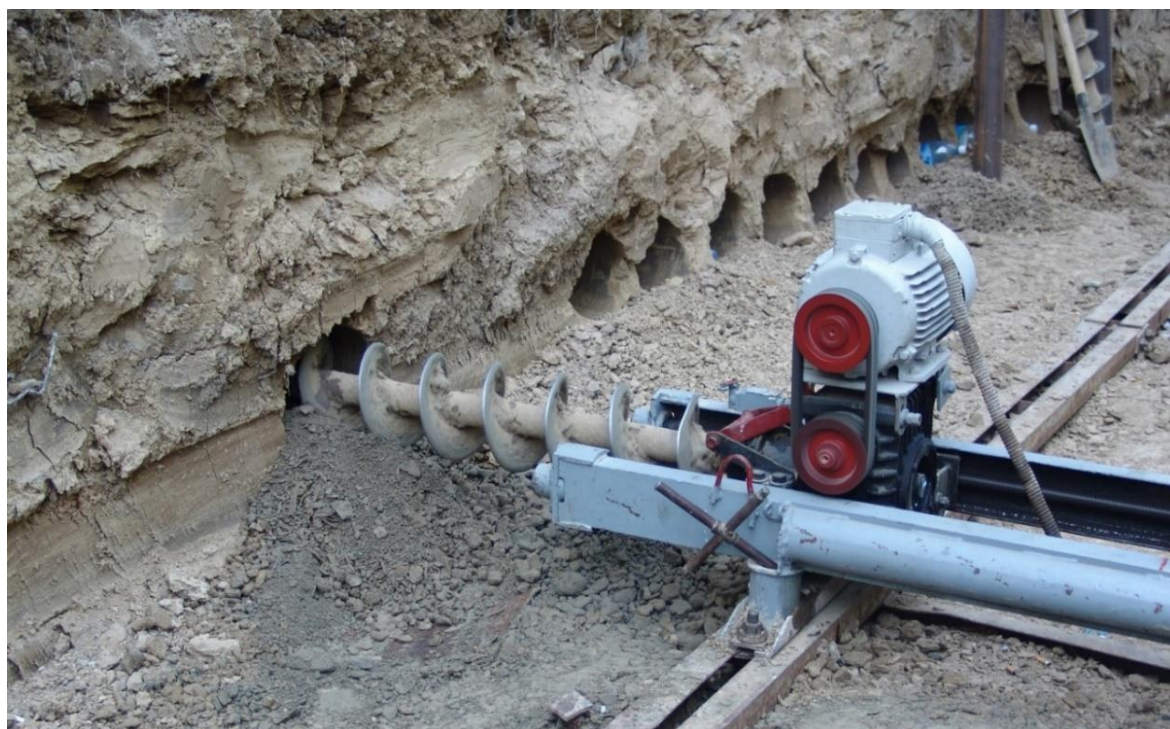
Рис. 2.31. Характерні контури свердловин після їх буріння в процесі усунення нахилу будівель та споруд.
