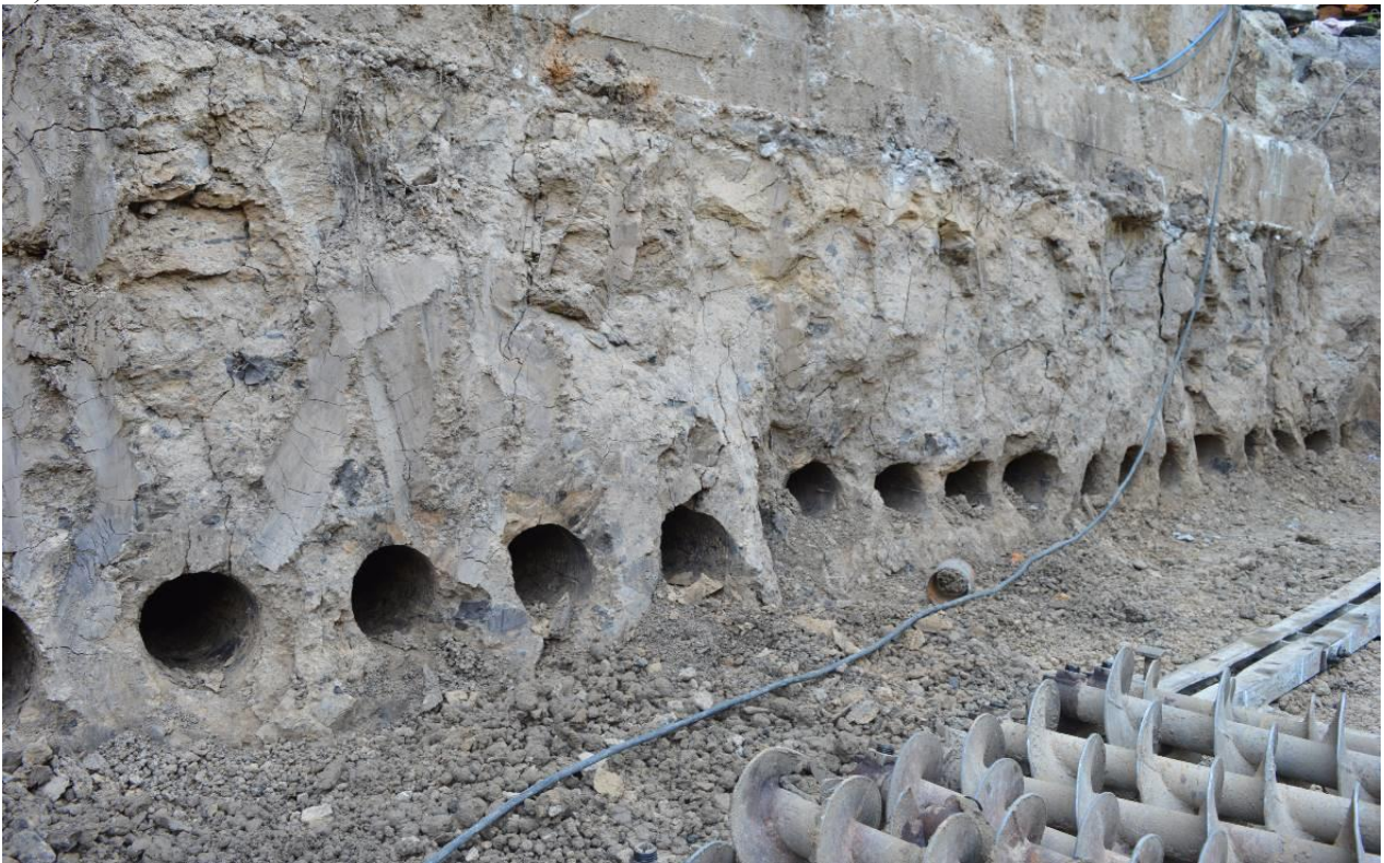
Рис. 4.6. Зовнішній вигляд перфорованої основи (а, б).
