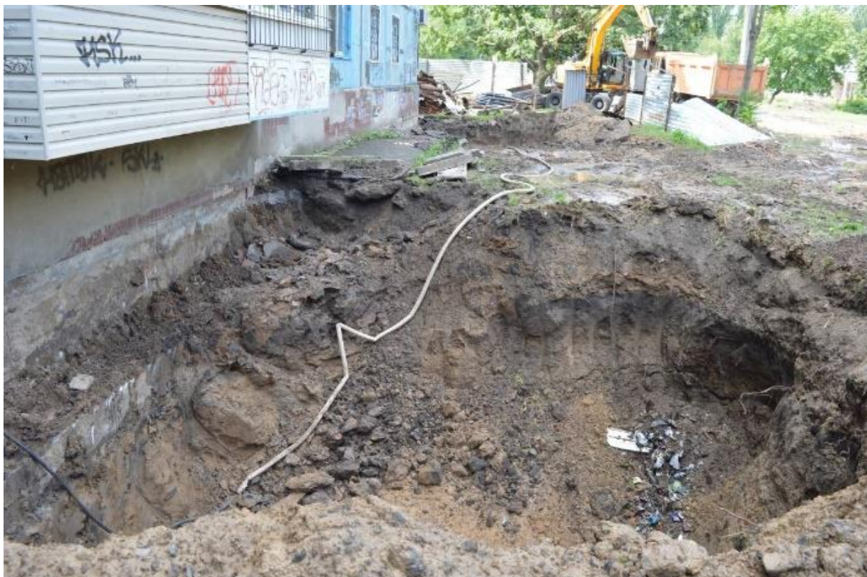
Рис. Г7.1 – Зовнішній вигляд під час відкопування котловану.
