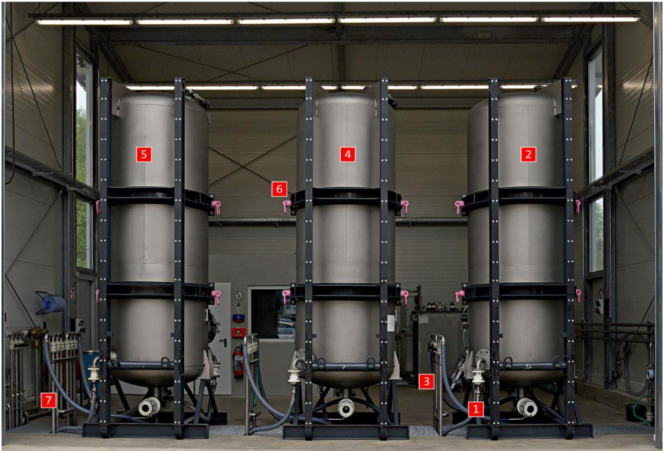
Рис. 25. Система очищення ґрунтових вод на майданчику Хуго 2/5/8 в Гельзенкірхені. Енергозабезпечення за рахунок фотовольтаніки на даху [25]
